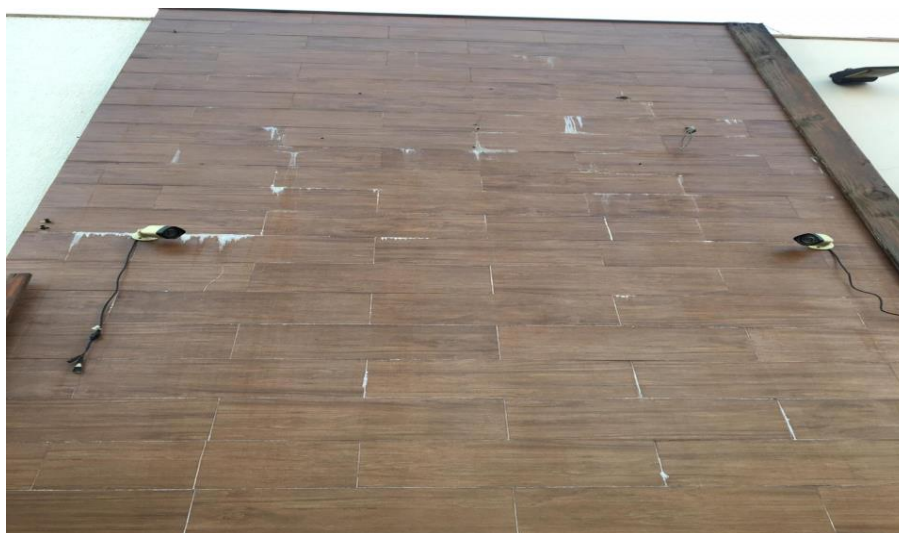
Figura 15 - Eflorescência, objeto de estudo B. Fonte: Próprio autor, 2019.
